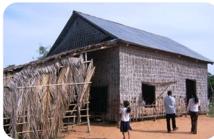
建設前の旧校舎
